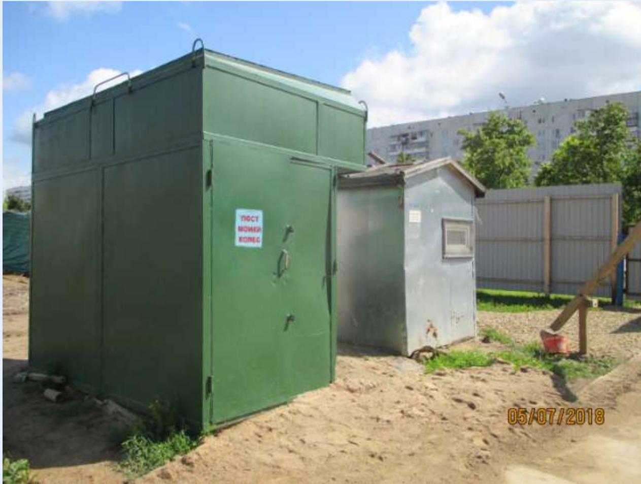
Пост мойки (очистки) колес
