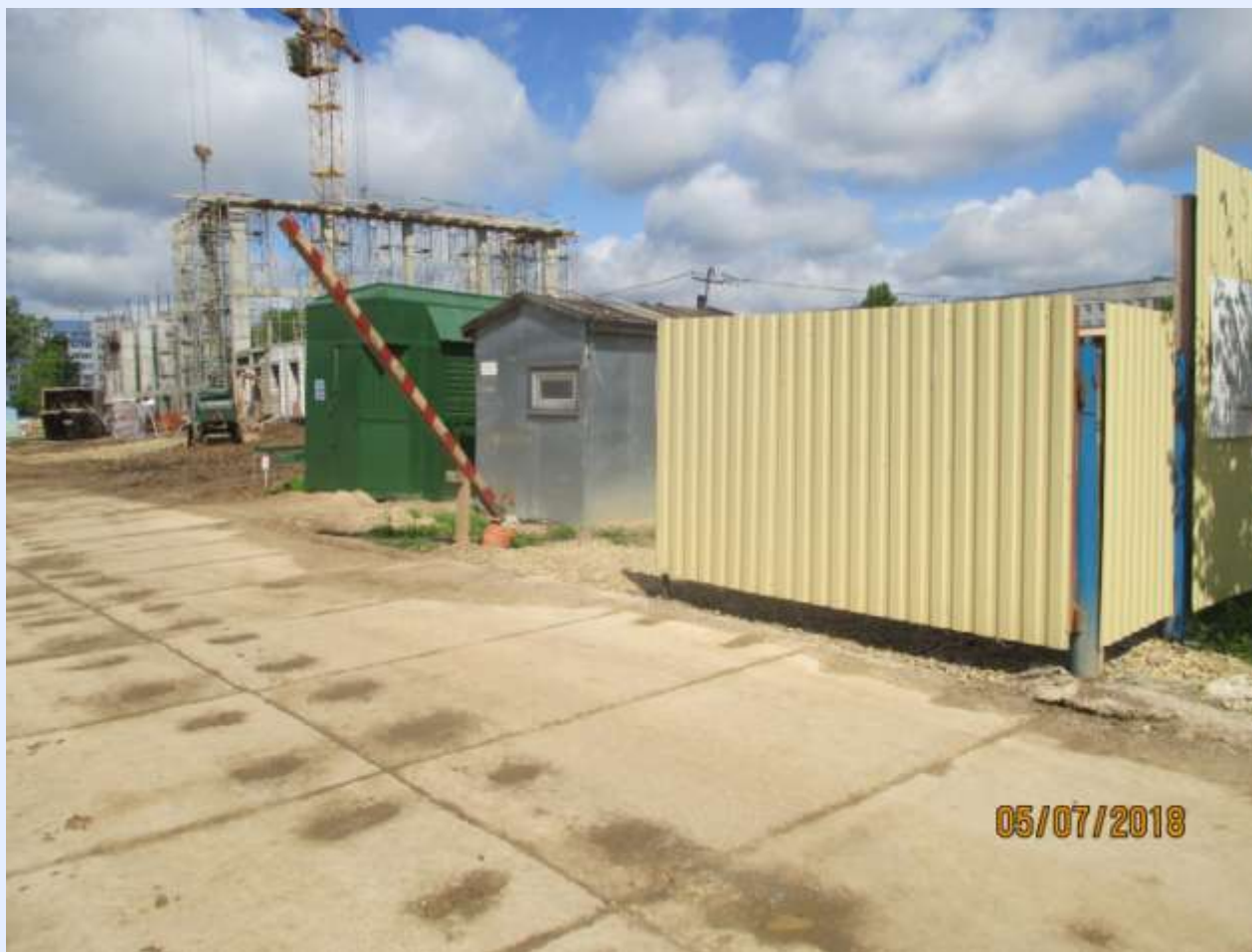
Въезд на строительную площадку
