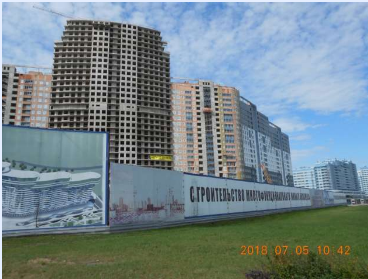
Ограждение строительной площадки
