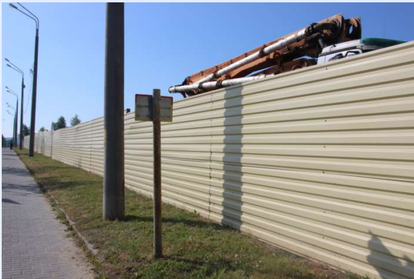
Ограждение строительной площадки
