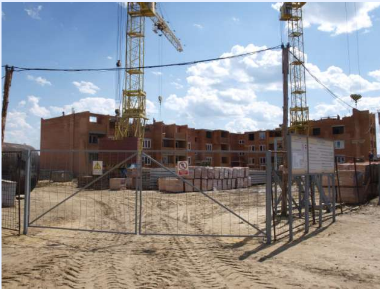
Въезд на строительную площадку
